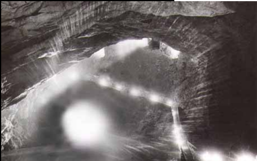
Новофонская пещера. Строительство пешеходной эстакады в зале Спелеологов. 1973 год.
