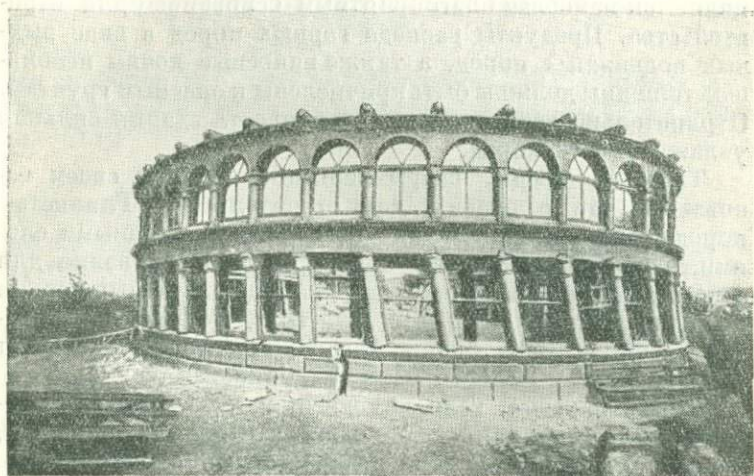
Фиг. 44. Здание Обсерватории в Сан-Франциско, пострадавшее при землетрясении 1906 г.
