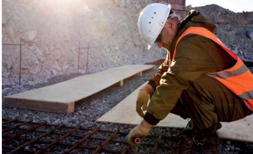
Рис. 2. Строительство фундамента рудо-перерабатывающего комплекса (РПК) на Биркачане
