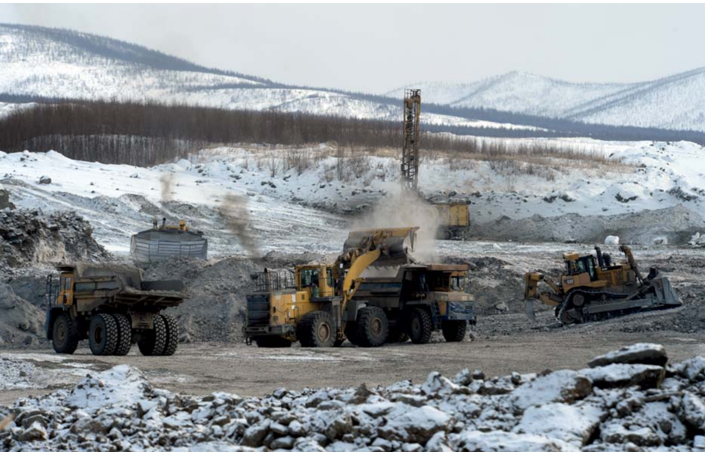
Зимняя вскрыша на одном из полигонов
