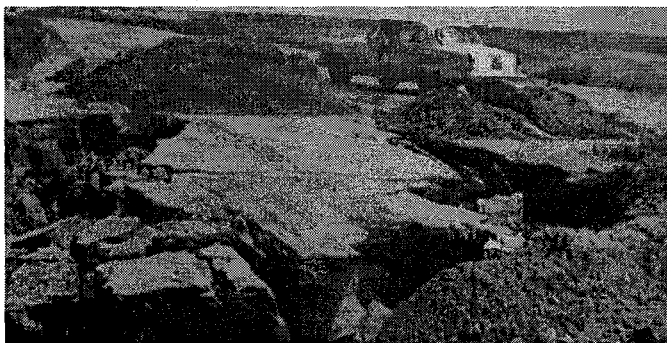
Рис. 2.3. Разрушение дорожного полотна шоссе, проложенного на лёссовых породах около г. Ашхабада [Соколов, 1996]
