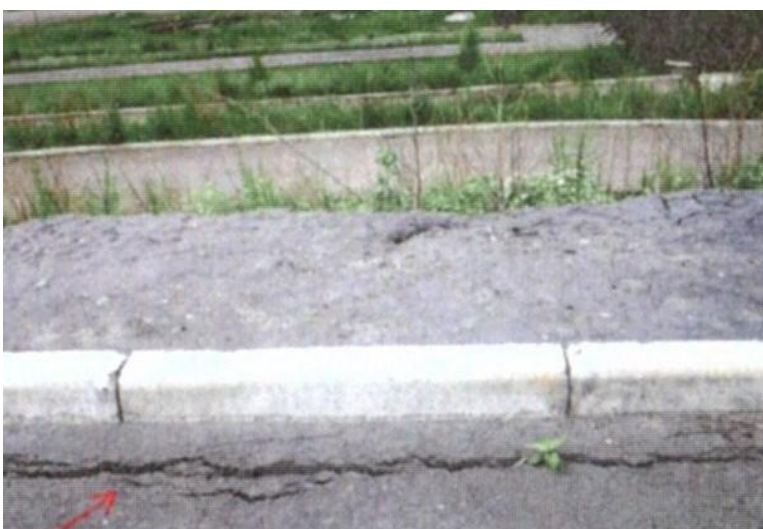
Рис. 26. Трещина в асфальте (А.В. Леонова, 2011)
