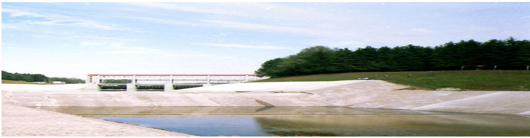
Рис. 4.1 Общий вид плотины
