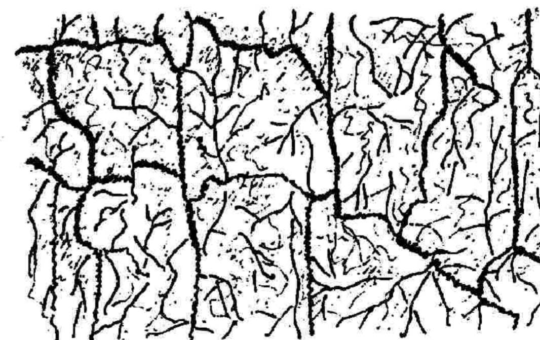
Рис. 4.5. Усадочные трещины грунта, уплотненного укаткой
