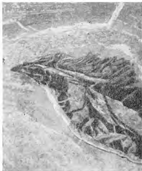
Рис. 1. Поперечный срез древесины на стенке горной выработки Соликамского рудника
