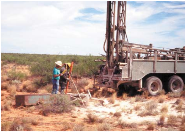
Рисунок 6.10. Обычная буровая установка.
