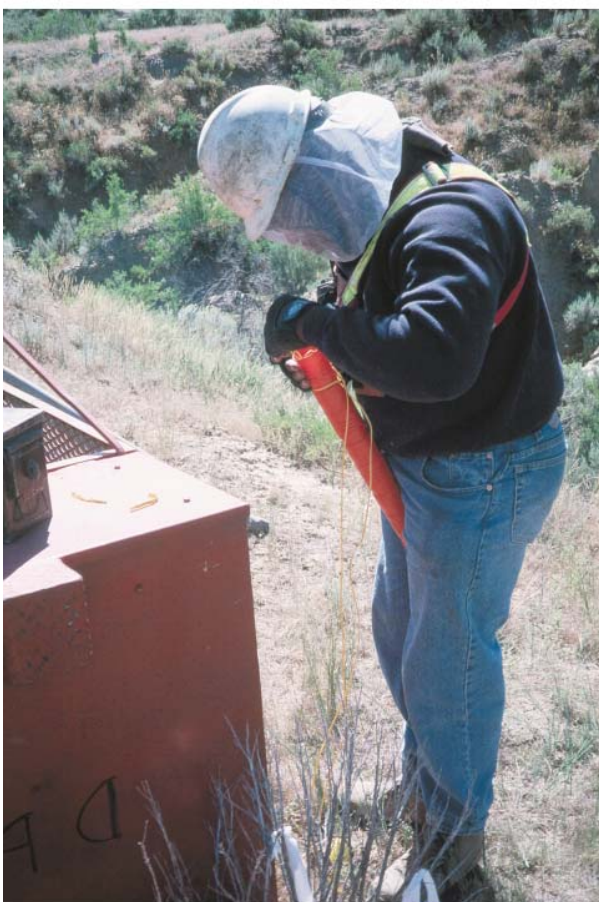
Рисунок 6.7. Подготовка динамитного заряда.
