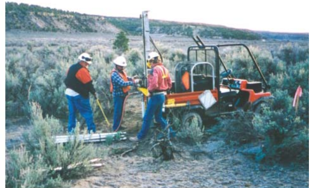
Рисунок 6.17. Небольшая буровая установка для взрыва в маленькой скважине.
