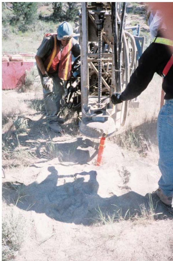
Рисунок 6.8. Заглубление заряда во взрывную скважину.
