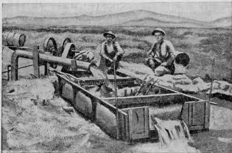
Рис. 48б. Складной водомер (по Мейнцеру и Кельтону).
