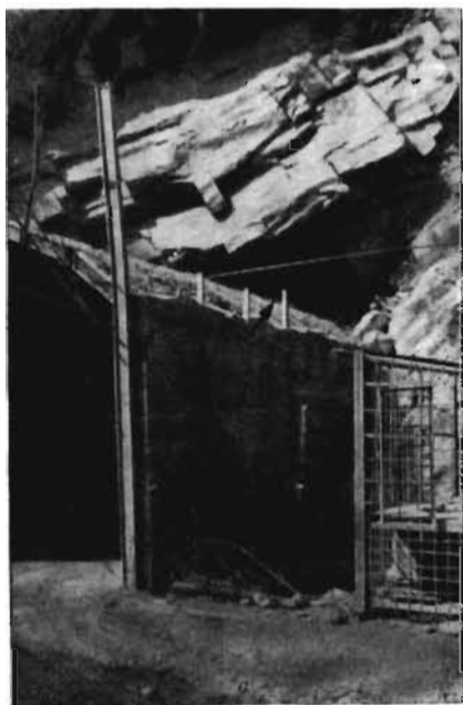
Рис. 33. Соотношение формы вывалов и формы туннеля
