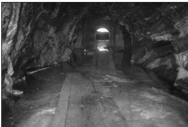
Рис. 10. Штольня Слюдяногорского месторождения мусковита
