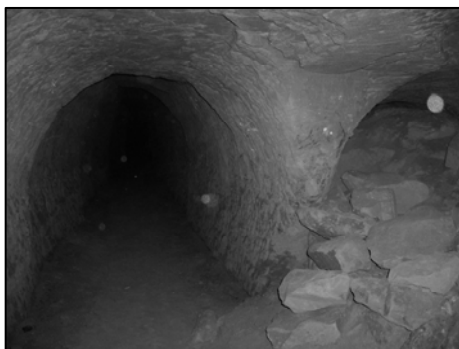
Рис. 9. Штреки двух типов: прямоугольные с относительно прямыми стенами и плоским потолком и узкие, с арочным округлым сводом и преимущественно прямыми стенами
